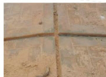
3. limpieza de juntas
