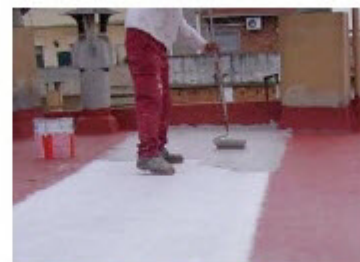
5. aplicación de fibra de vidrio
