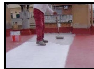
5. Aplicación de fibra de vidrio
