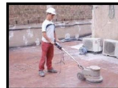
2. Limpieza y preparación del soporte
