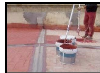
4. Formación de juntas e imprimación de la superficie con caucho diluido
