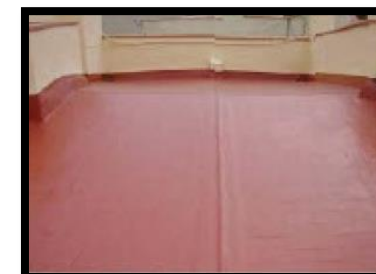
6. Aplicación de las siguientes capas de caucho acrílico y acabado final
