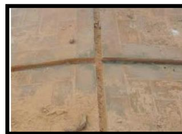
3. Limpieza de juntas
