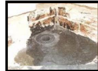
Colocación sobre imprimación de masilla de poliuretano
