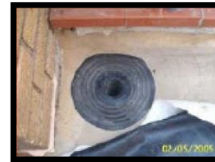
Presentación de pieza prefabricada de embocadura de desagüe
