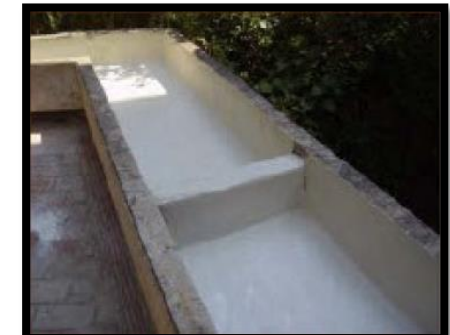
Detalle de acabado con mortero anti-raíces, con malla de fibra de vidrio intercalada
