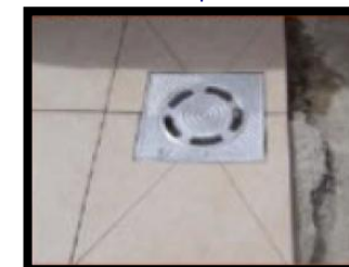
Colocación sobre imprimación de masilla de poliuretano
