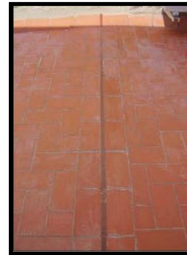
Acabado junta de dilatación
