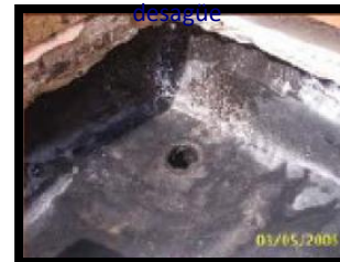
Colocación de lámina de EPDM sobre embocadura de desagüe
