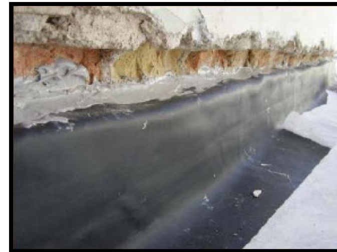
Detalle de solape con paramento vertical
